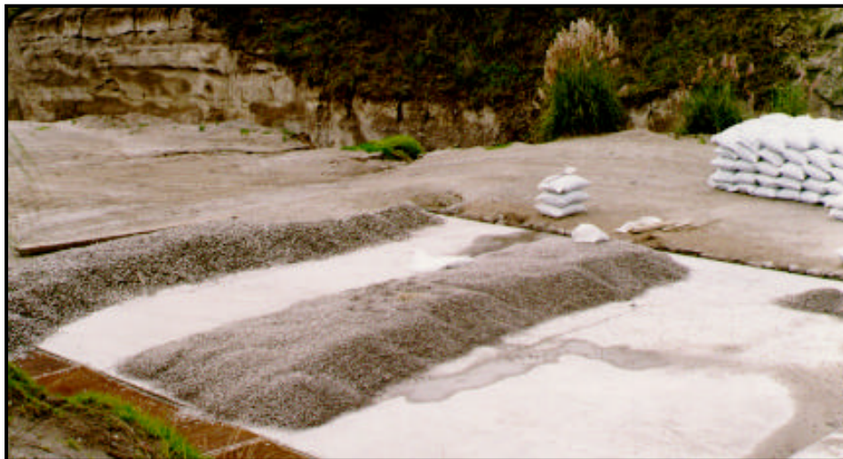
Figura 1.9 Losa para Secado y Escurrido de Piedra Pómez
