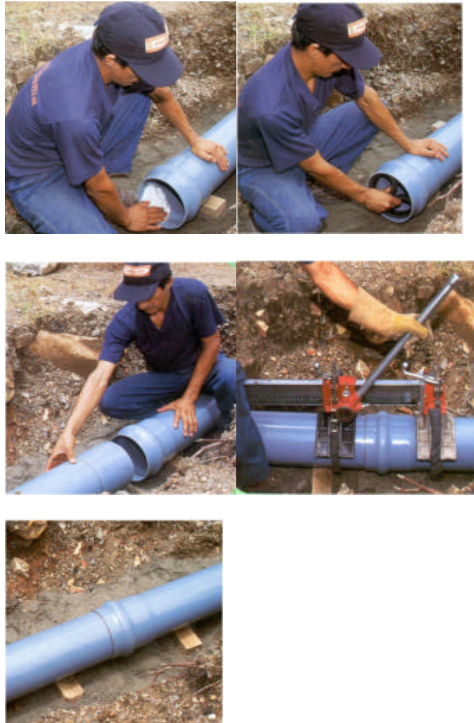
Figura 3.35 Secuencia de Unión Mecánica
