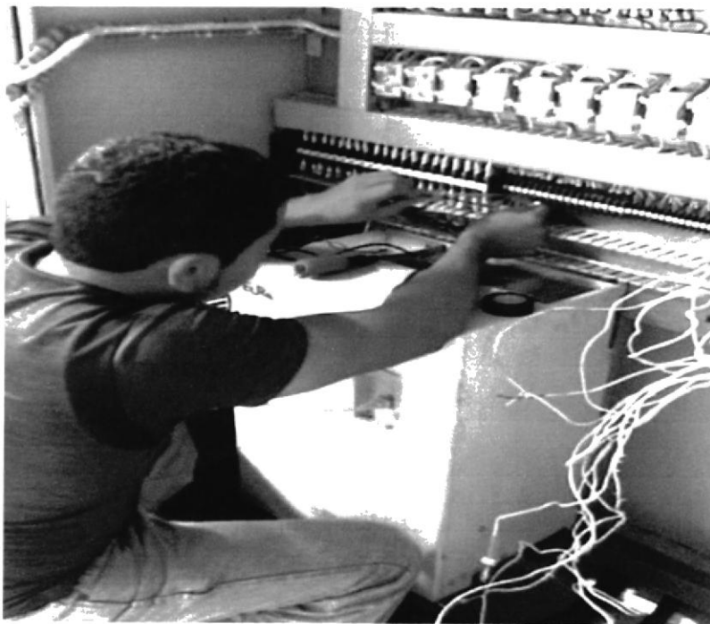
Figura 14. Momentos en que me encuentro instalando el motor principal y cada uno de los controles de las resistencias.
