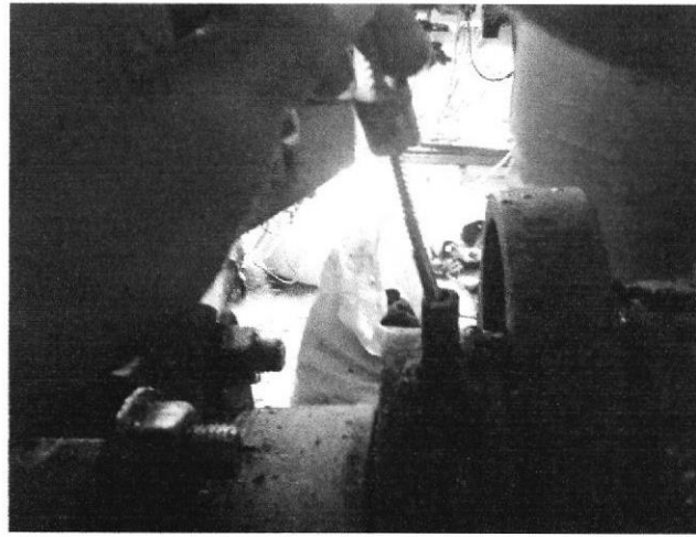
Figura3: Instalación de la termocupla tipo J
