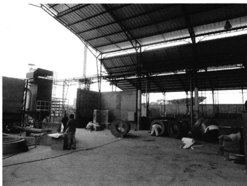
Figura 3.- área de refinación de la planta CME
