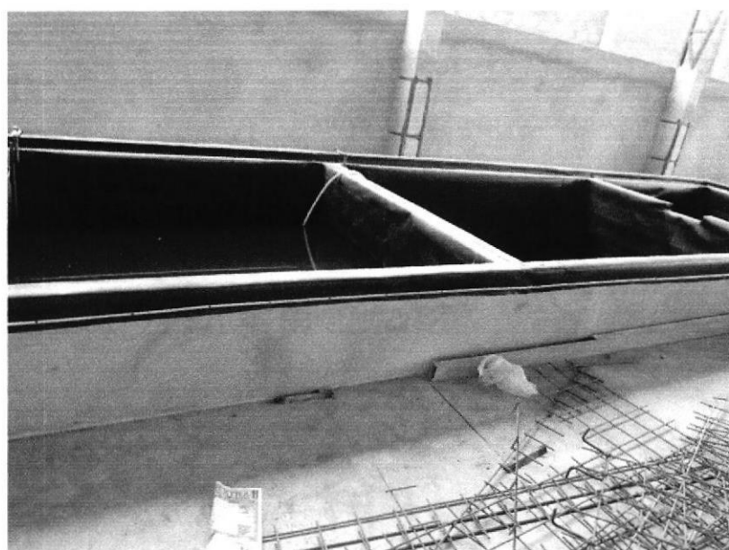
Figura 4.- área de ruptura de baterías de la planta CME
