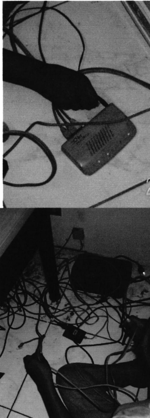
FIG. 15: Des energizando y desconectando equipos
