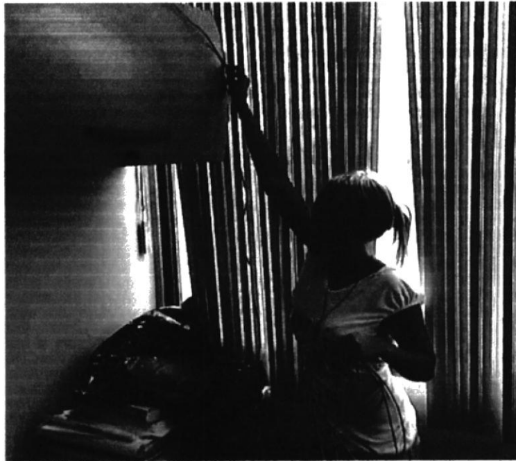
FIG. 16: Desmontando cables en mal estado
