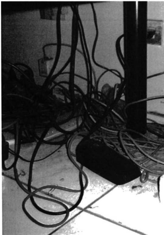
FIG. 11: Situación inicial del cableado-switch ubicado en el suelo
