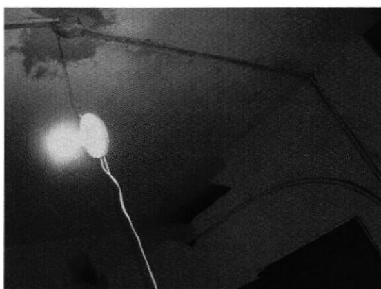
Fig.12. Tubería de Alumbrado.
