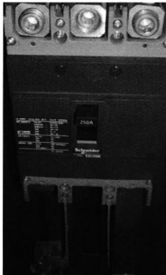
Fig.29. Disyuntor Principal.
