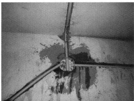
Fig.10. Caja de paso.
