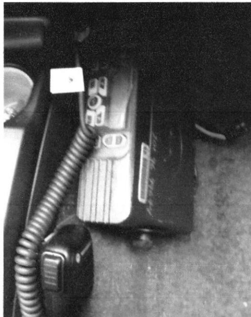
Gráfico 3-12: Instalación de la radio
