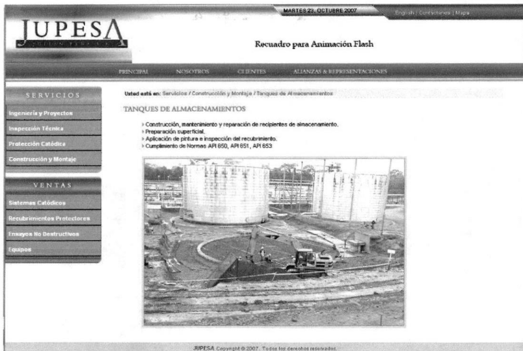
Figura 3.31 Página Tanques de Almacenamiento
