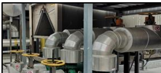
Figura 1.12 Chiller – Sistema Enfriamiento por Agua
