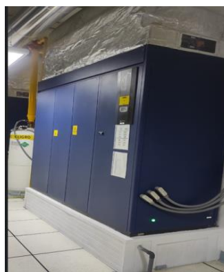
Figura 1.10 Unidad Manejadora de Aire Uniflair
