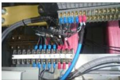
Figura 1.23 Conexionado de Red en equipos Modbus
