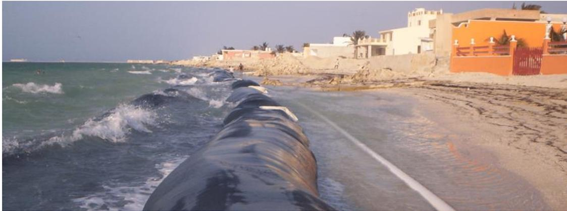
*Nota:* En la figura se muestra la función estabilizadora de un geotubo para la playa. Tomada de “Construcción Marítima y Obra General” por Constructora Pech. 2020. <https://constructorapech.com.mx/2020/07/30/geotubos-contralaerosion/>
