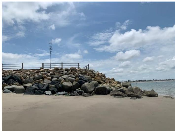
*Nota:* Imagen tomada desde el lado derecho del espigón, mirando al mar, donde se aprecia el deslizamiento de piedras en la cabecera del mismo, así como el movimiento de los barandales y la disposición aleatoria de piedras para mitigar el embate del oleaje en dicha área.
