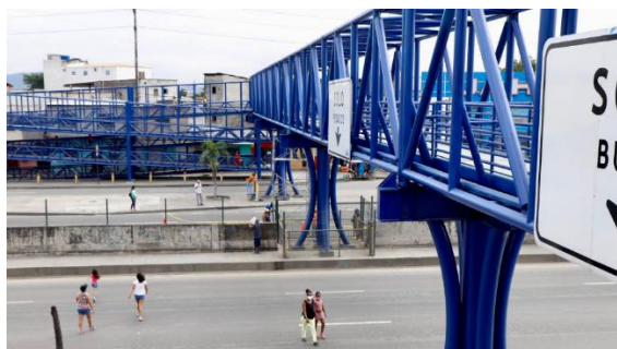
Puente tipo viga
