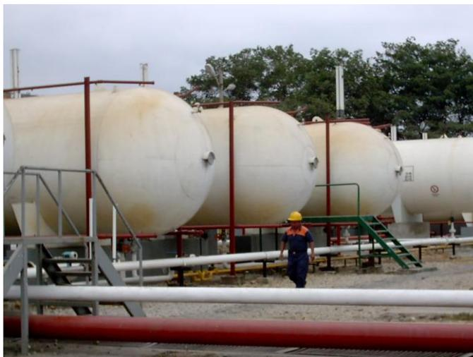
Figura 3 Estacionarios en una Planta de envasado de GLP
