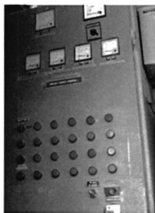
Figura 2.7 Tablero Arrancadores Secundaria -Figura 2.8 Tablero de Arrancador Primaria
