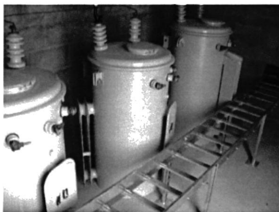
Figura 6.2 Instalación de Electro-canales en Subestación Primaria
