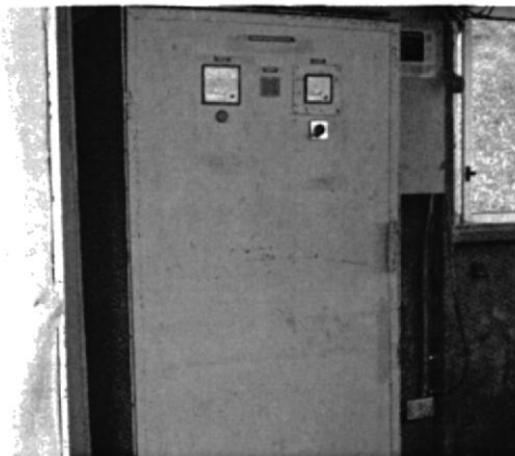
Figura 2.7 Tablero Arrancadores Secundaria -Figura 2.8 Tablero de Arrancador Primaria
