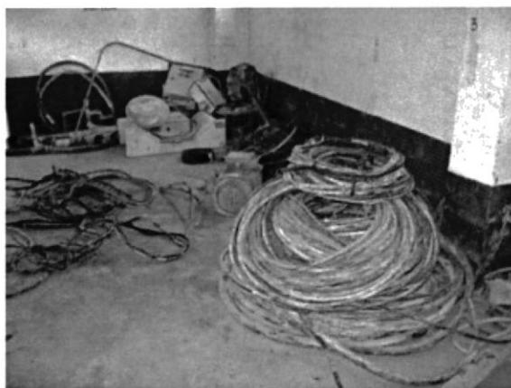
Figura 3.9 Tabla de Material Eléctrico bloque 2 y material eléctrico en bodega
