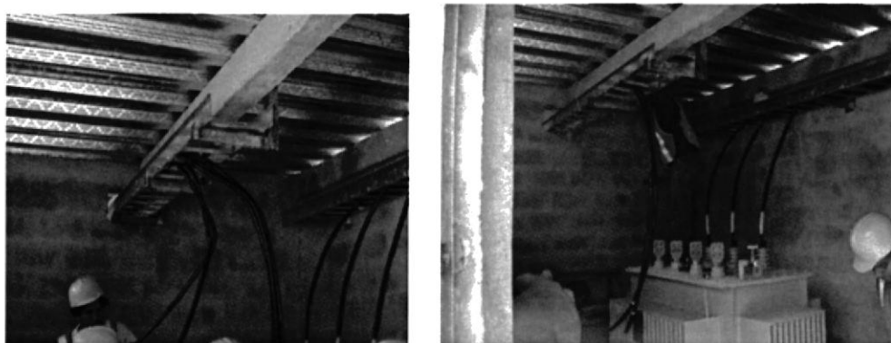
Figura 6.1 Instalación de Electro-canales en Subestación Secundaria-Terciaria
