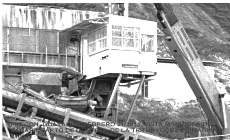
Figura 2.4 Caseta de control primaria
