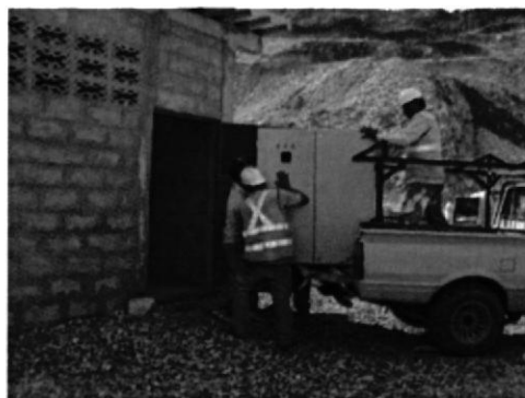
Figura 6.6 Tablero de Distribución Restaurado Sección Primaria
