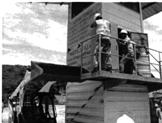
Figura 6.9 Desmontaje de tableros de arrancadores y distribución sección secundaria
