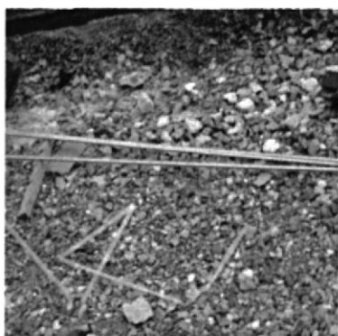
Figura 7.2 Sistema a Tierra
