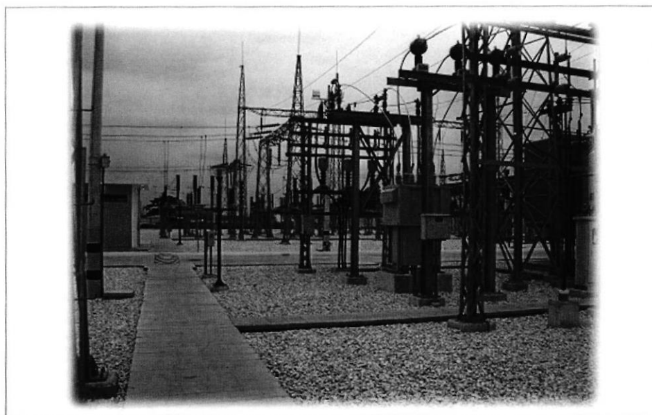
Fig. 22 : ALIMENTACION DE TERCIARIO 13.8KV
