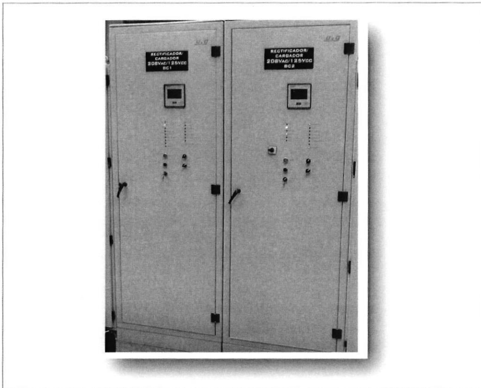
Fig. 27 : EQUIPO CARGADOR RECTIFICADOR
