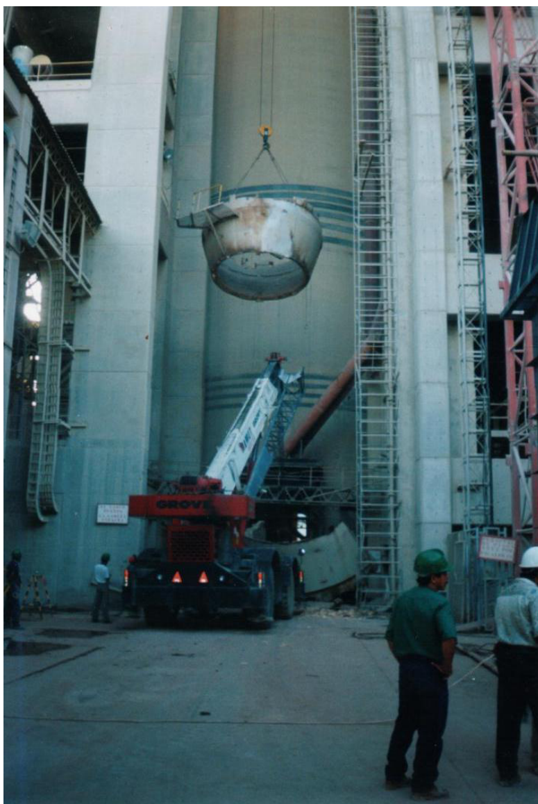
FIGURA 4.1. DESMONTAJE DE SECCION CONICA DE CICLON
