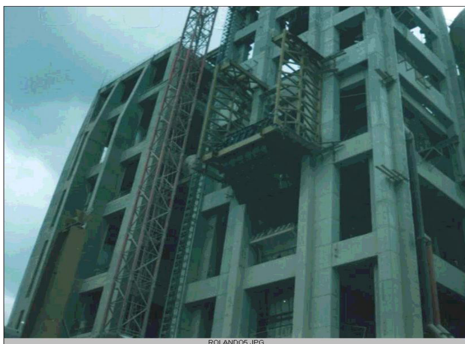
FIGURA 4.2. MONTAJE DE DUCTO EXTERIOR DEL CALCINADOR
