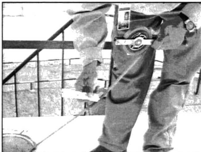
**Figura 5-3:** Cinta de medición con pasta indicadora de agua
