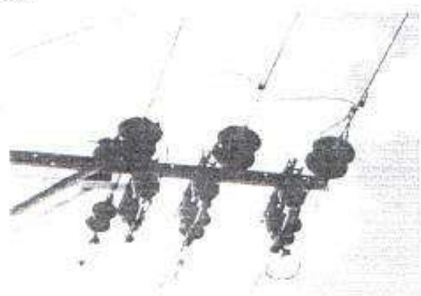
Fig. 8.1. Seccionador del tramo de la calle José F. de Valdivieso.
