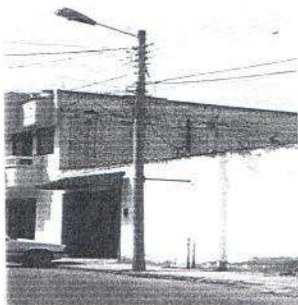
Fig. 2.4. Poste de 9 metros.
