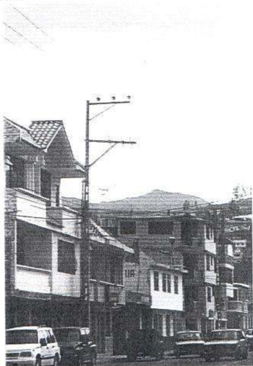
Fig. 2.5. Poste de 14 metros.
