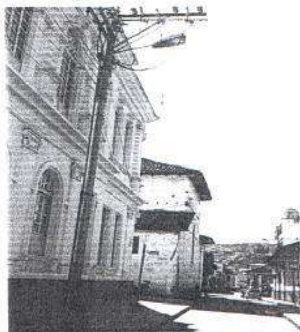
Fig. 2.22. Tensor a tierra con poste pequeño.
