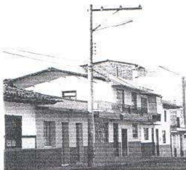
Fig. 2.3 Poste de 11 metros de concreto, con red de alta y baja.
