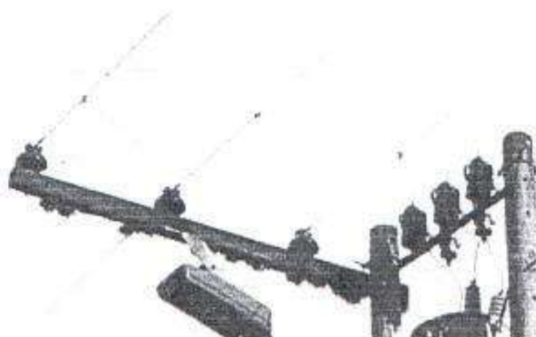
Fig. 2.30. Transformador # 560 sin grapa de línea viva en la red.
