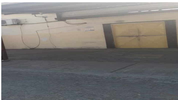
Figura 43 Sala del área de emergencia
