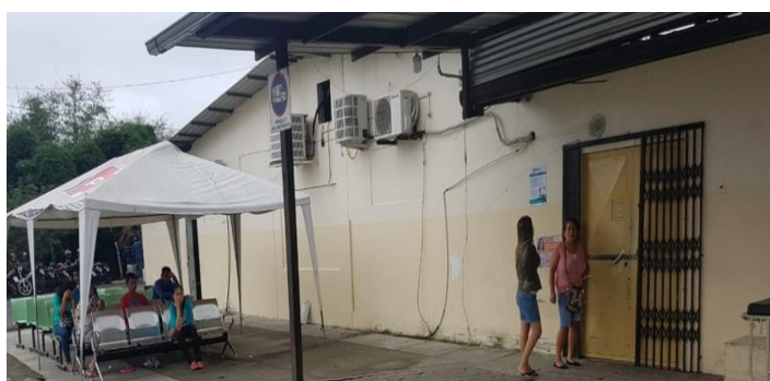
Figura 8 Sala de espera de emergencia
