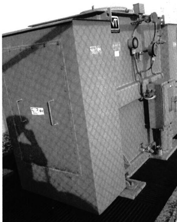
Figura 2.6 Transformador Auxiliar 2.
