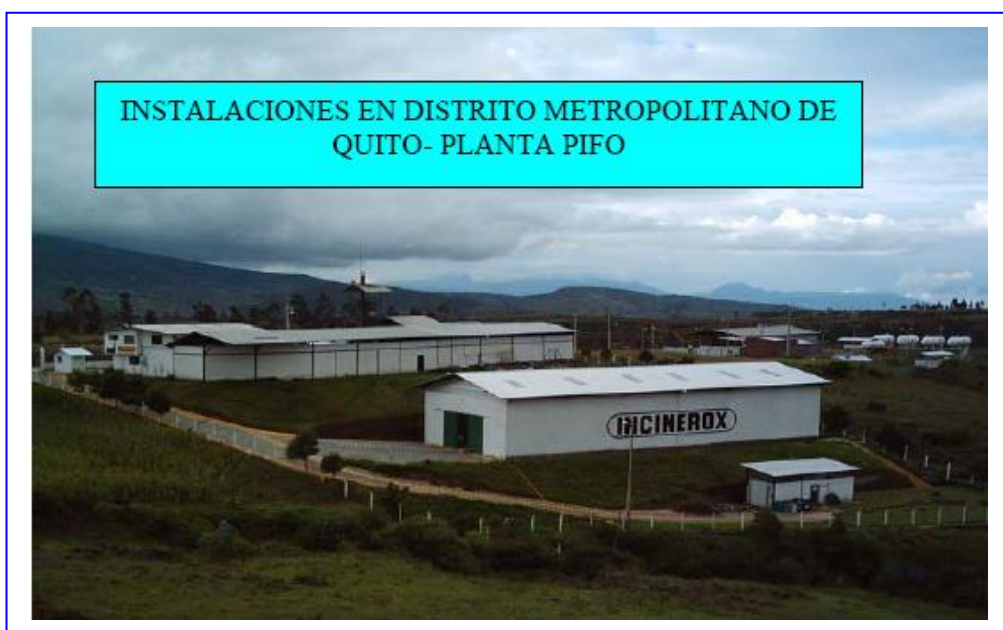
Fig. 3.13 Planta de Incineración de Ripios, Foto Cortesía de la Empresa INCINEROX proporcionada en abril del 2007.
