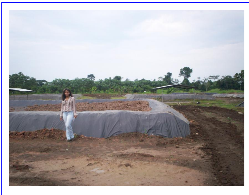
Fig.3.22 Unidad de Lechos o de Landfaming, tomada en Cañón de los Monos del Coca, Cristina Ballesteros, febrero 2007.
