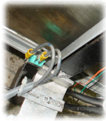
Figura 52.: Final de Carrera Presionado por la Cabina
