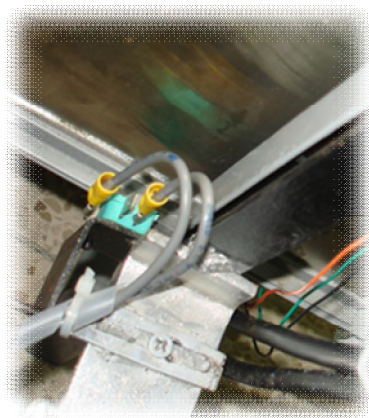
Figura 52.: Final de Carrera Presionado por la Cabina
