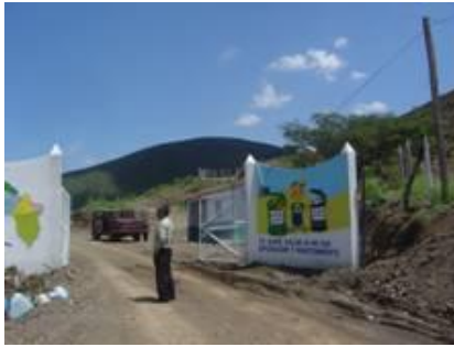
Puerta de ingreso al Relleno Sanitario de Catamayo
