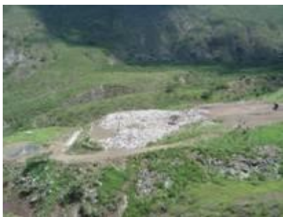
Celdas de Residuos Sólidos del Relleno Sanitario Catamayo.
