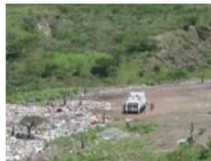
Carro recolector depositando residuos sólidos, en la Celdas de residuos sólidos.
