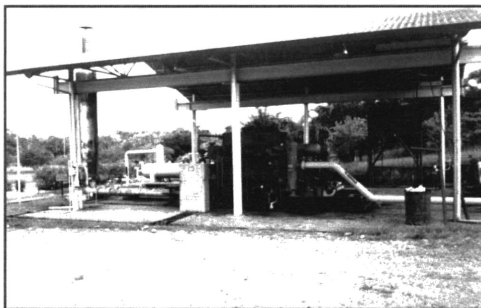
FIGURA 3.9. COMPRESOR RECIPROCANTE.
