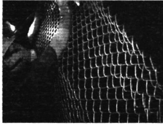
Foto 5.6. Colocación de la malla de eslabones
