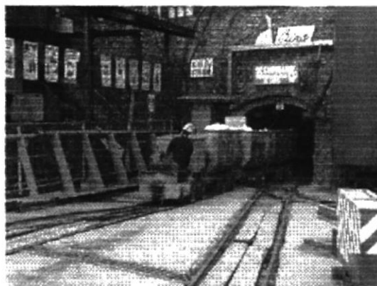
Foto 4.1. Se observa la locomotora a la salida de la bocamina con su respectivo convoy de carga
