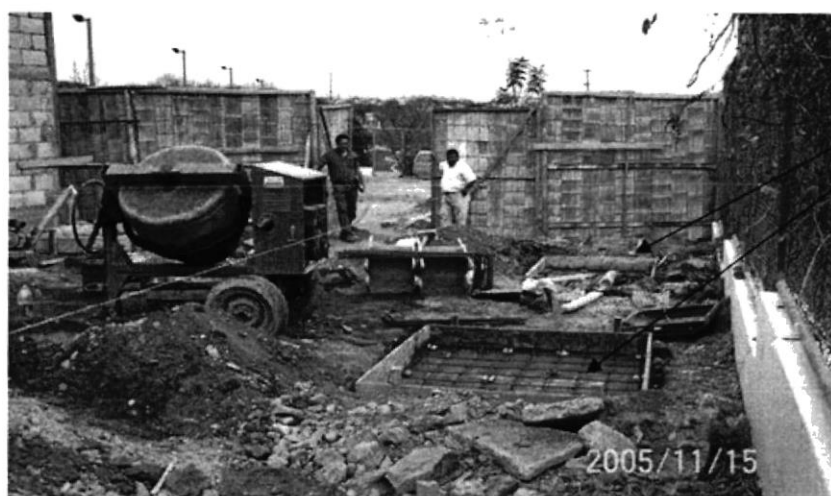
Plintos de Ampliación
