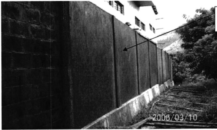
CERRAMIENTO DE HORMIGÓN
