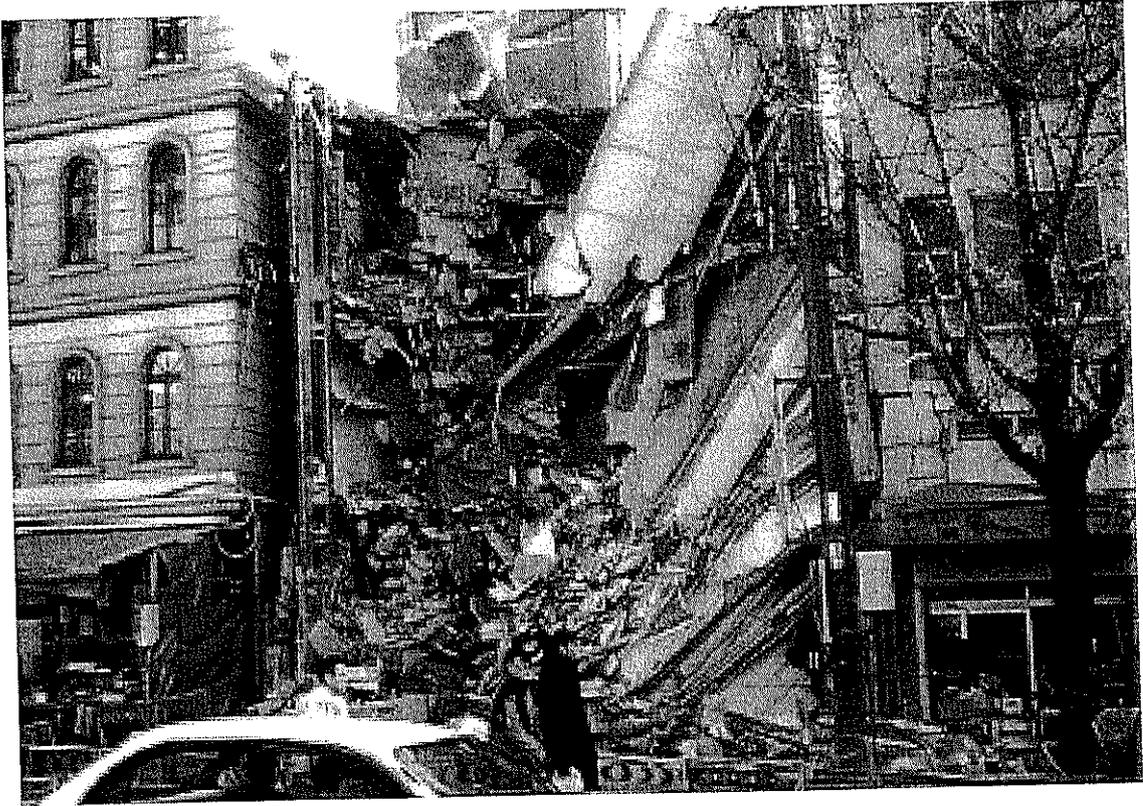
Figura 1.1 Colapso de edificio metálico durante el terremoto de Kobe de 1995
