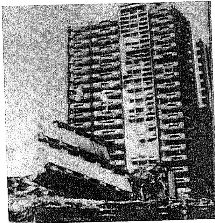
Figura 2.16 Colapso de un edificio del Complejo Pino Suárez, sismo de la Ciudad de México, 1985. (Tomado de FEMA-355D).
