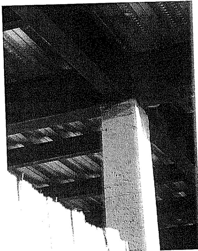
Figura 2.3. Unión vigas columna, donde se observan que la columna se interrumpe en la intersección con las vigas (Tomado de Cassagne 2008).
