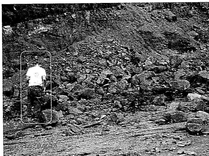
Figura 5.6.1 Deslizamientos de cuñas en lado izquierdo del vaso principal.
