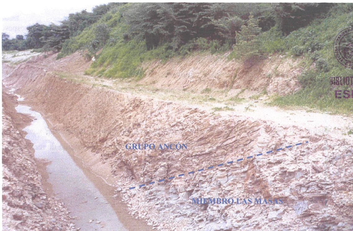
Figura 2.7 – El contacto entre el Miembro Las Masas y el Grupo Ancón puede ser visulizado en el canal de desagüe de agua del yacimiento de caliza.
