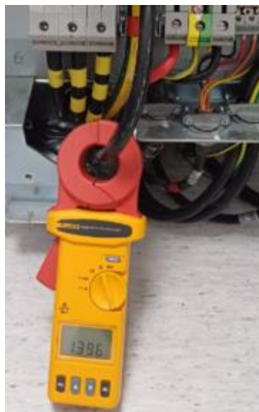
Figura 3.20 Medición de tierra del sistema (Fuente: Autor)
