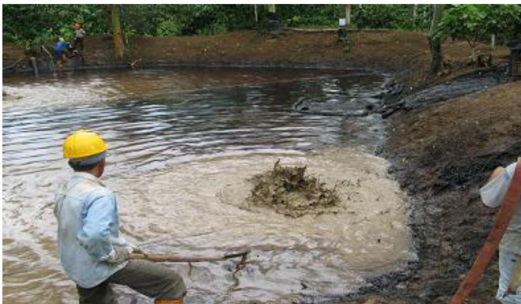
Figura 4.5. Limpieza de suelo contaminado.
