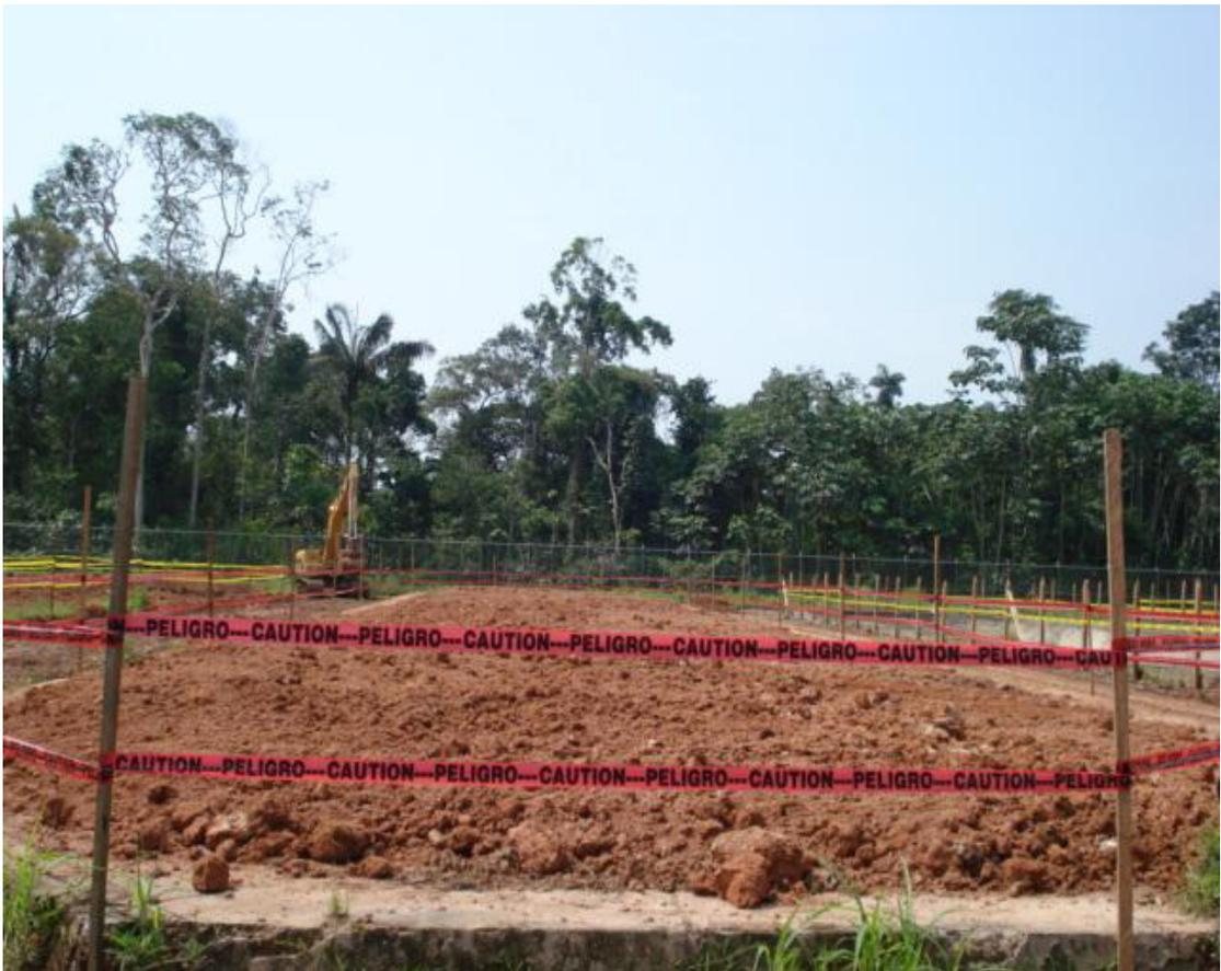
Figura 4.9. Piscina donde se entierra el material solidó de perforación
