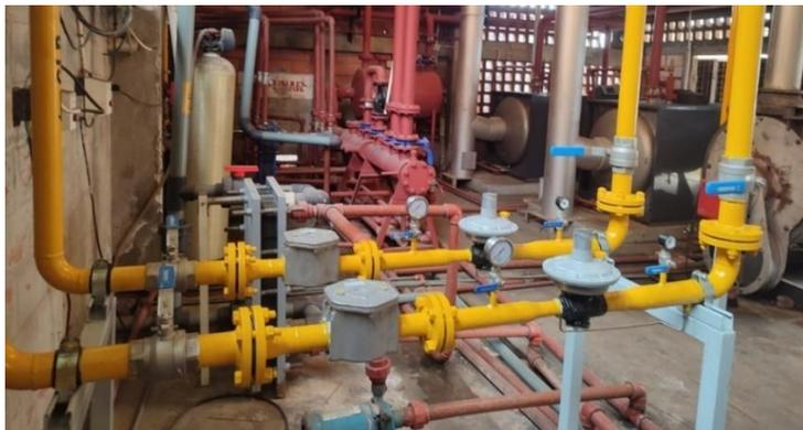
*Nota.* La figura muestra el tren de regulación de segunda etapa para equipos 5, 6,7 y equipos 8 y 9. Fuente propia.
