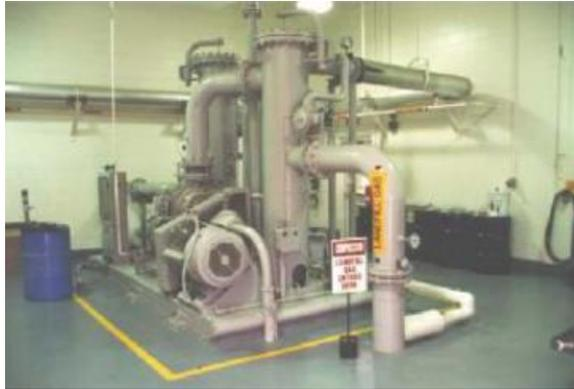
(b) Filtración de gas e intercambiador de calor
