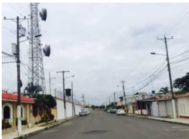
Figura 17. Vista de la entrada al Data Center Duran
