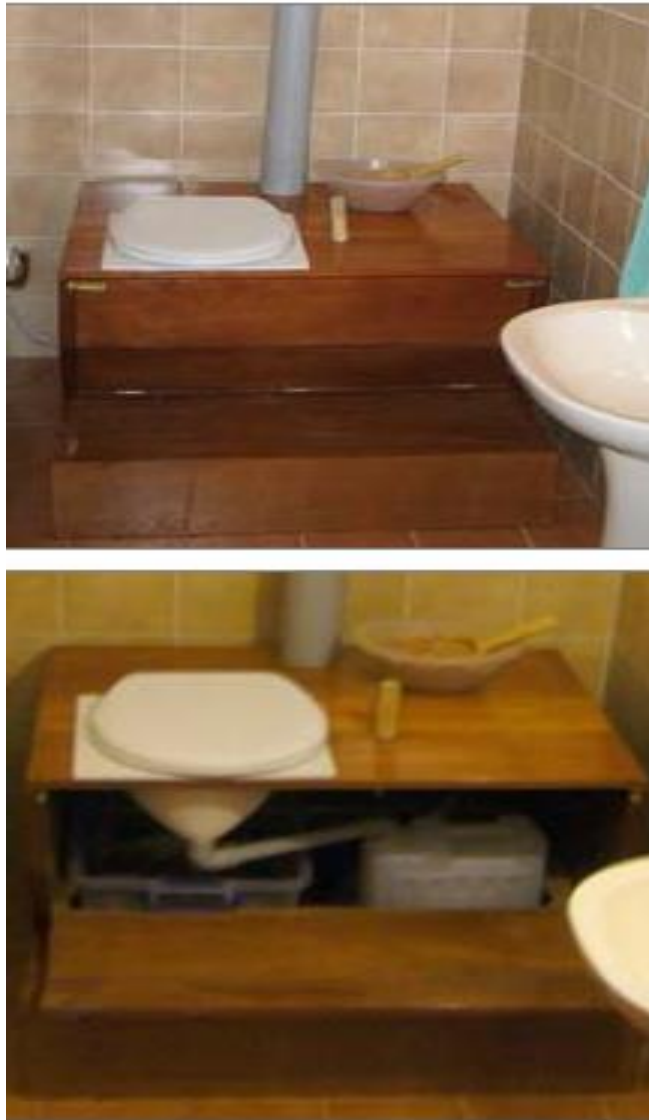
Figura 6. Modelo de Sanitario Ecológico
