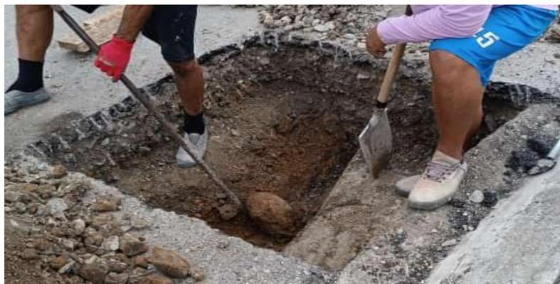
Al realizar la excavación se logró constatar que la estructura del pavimento tenía altos niveles de humedad, esto puede estar asociado a la presencia de una alcantarilla y un área verde cercano al lugar de la toma de las muestras.
