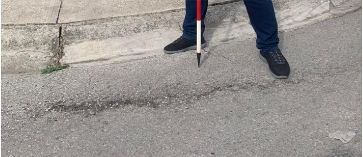
En esta zona de daño se puede observar el levantamiento de la carpeta asfáltica, este punto se encuentra cerca de una acera que presenta fisuras alrededor de una alcantarilla de aguas servidas, además se puede observar como la base de la acera se encuentra sin relleno.
