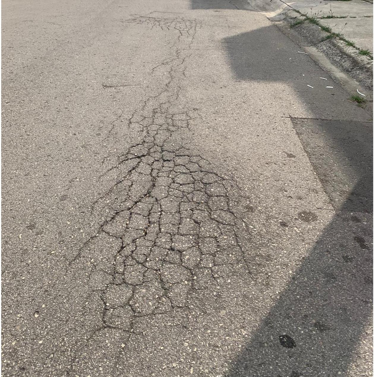
En la zona 5 se encuentra ubicada en la avenida principal, entre los solares 25 y 26 de la manzana 2551, el problema a revisar es acerca que el pavimento flexible muestra signos evidentes de deterioro, se identifican daños de hundimiento y piel de cocodrilo, en la inspección visual se pudo observar que este daño es el que tiene un hundimiento considerable en el centro de la calle
