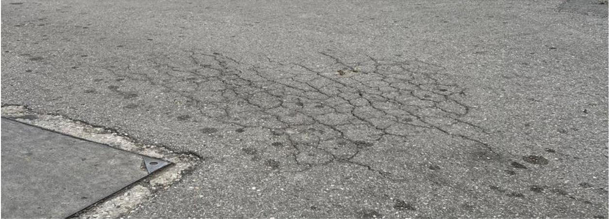
La zona de daño 2 se encuentra ubicada en la avenida principal, en cerca del solar 5, el problema a revisar es acerca que el pavimento flexible muestra signos evidentes de deterioro, se identifican daños de hundimiento y piel de cocodrilo en el centro de la calle sugiriendo la presencia de fatiga en la carpeta asfáltica y en las capas inferiores de la estructura del pavimento.
