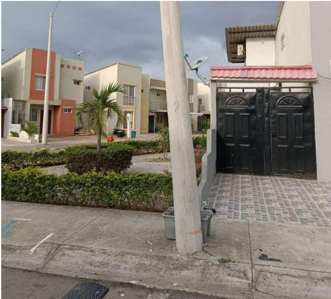
En esta zona de daño se puede observar hundimiento en la acera, generando que un poste de luz se incline, esto genera una sensación de peligro en los habitantes del sector.
