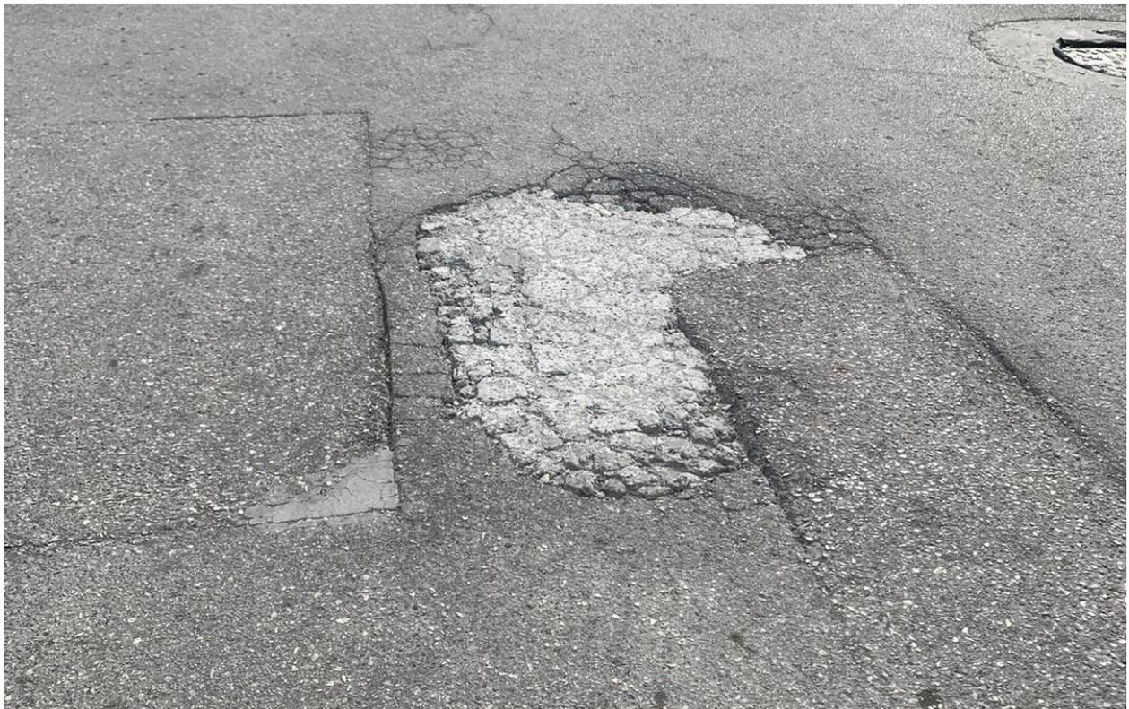
En la zona 4 se puede visualizar un deterioro significativo en el pavimento flexible en forma de baches que han sido reparados con una solución rápida y se compone de alrededor de 3 parches, 2 de ellos fueron parchados con asfalto y el tercero con hormigón, se puede notar por el color y textura del material que fue usado sin embargo esta solución ya comenzó a deteriorarse y presenta desprendimiento de fragmentos del hormigón.
