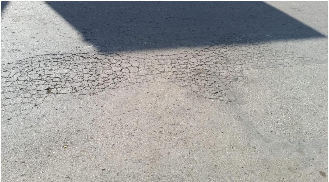
Esta zona se encuentra ubicada en la calle 2da, entre los solares 3 de la manzana 2556 y 24 de la manzana 2557, en esta calle se puede observar la piel de cocodrilo más extensa, con hundimiento sugiriendo la presencia de fatiga en la carpeta asfáltica y en las capas inferiores de la estructura del pavimento que se puede dar por las cargas de tráfico.
