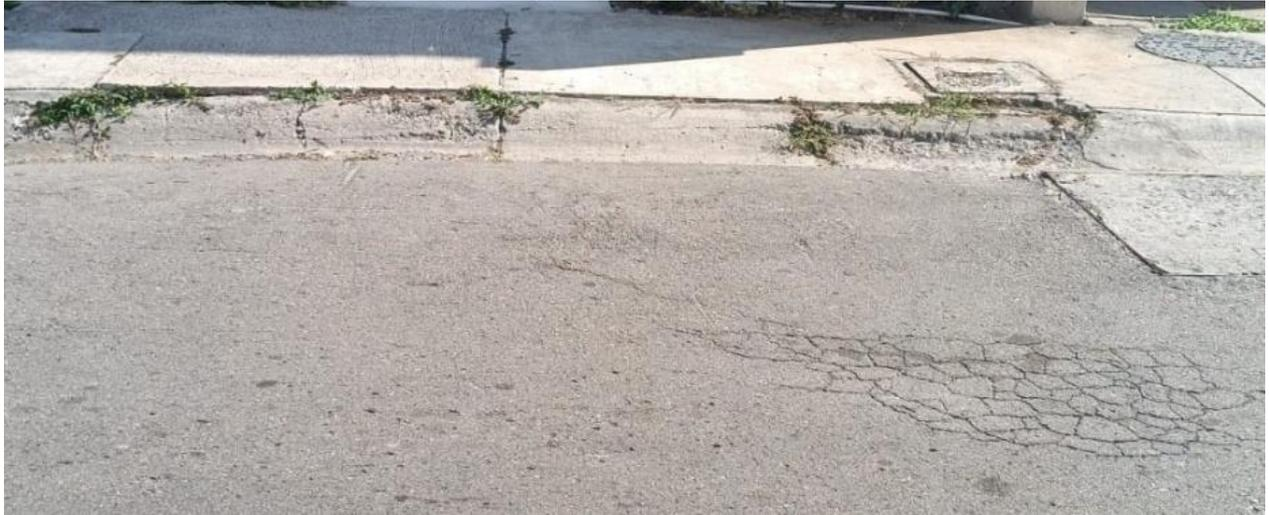
En la zona 6 se encuentra ubicada en la avenida principal, en el exterior de los solares 27 y 28 de la manzana 2551, el problema a revisar es la erosión y hundimiento de los bordillos cunetas que genera el estancamiento de agua, además de la presencia de piel de cocodrilo que en época de lluvia filtra agua a las capas inferiores.
