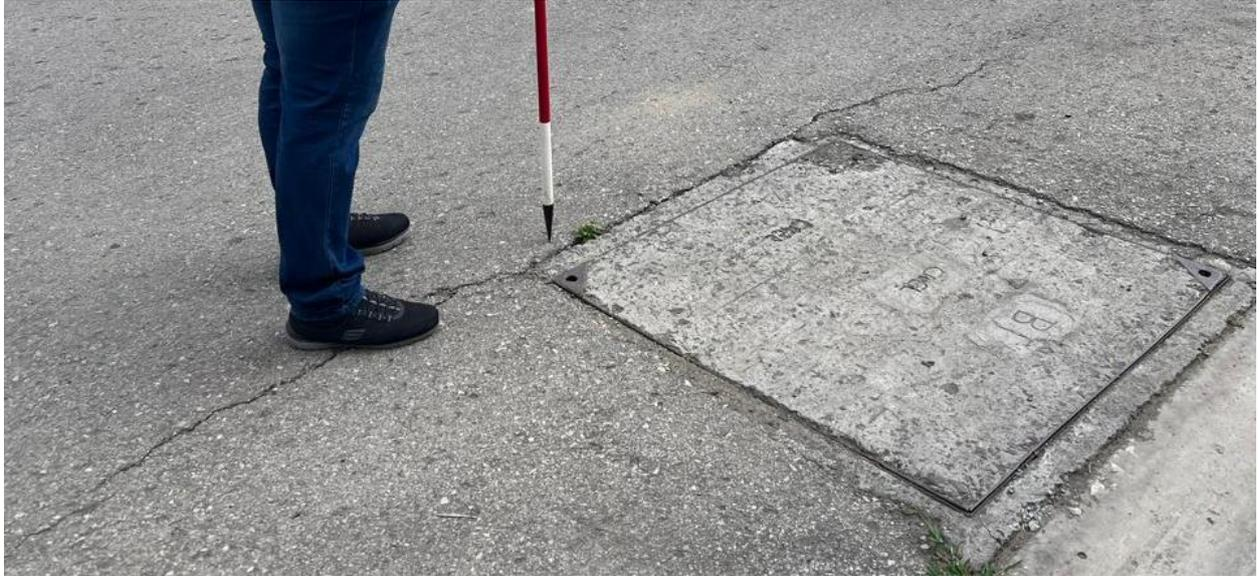
En la zona 8 se encuentra ubicada en la avenida principal, en el exterior del solar 36 de la manzana 2551, el problema a revisar es acerca que el pavimento flexible muestra una fisura longitudinal en la carpeta asfáltica cerca de la misma se encuentra una caja de CNEL para las acometidas eléctricas subterráneas.
