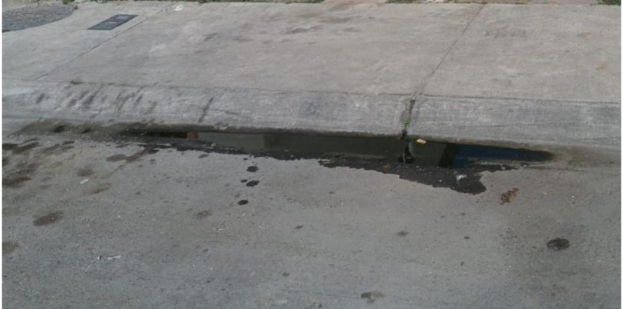
La zona 2 se encuentra ubicada en la calle 2da, entre los solares 3 de la manzana 2556 y 24 de la manzana 2557, se puede observar el estancamiento de agua debido a problemas constructivos de los bordillos cunetas, en esta calle los bordillos cunetas son un problema común dado que en sectores sí posee la media caña para permitir el paso del agua hacia los sumideros y en otros se comportan como rampa, esto causa que el estancamiento de agua sea común.
