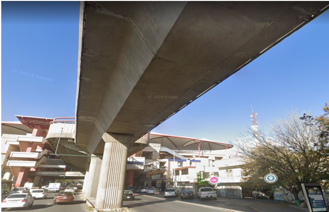
Figura 20 Imagen representativa de las dovelas aplicadas en la superestructura de la línea 1 del metro de Monterrey.
