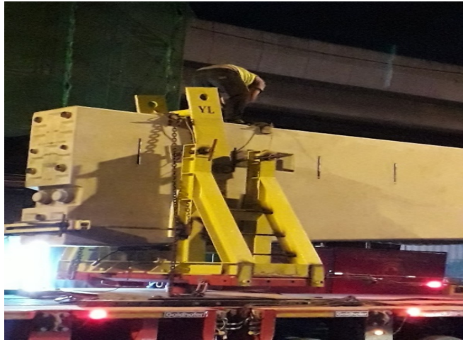
Figura 60 Dispositivo de izado de viga para monorriel
