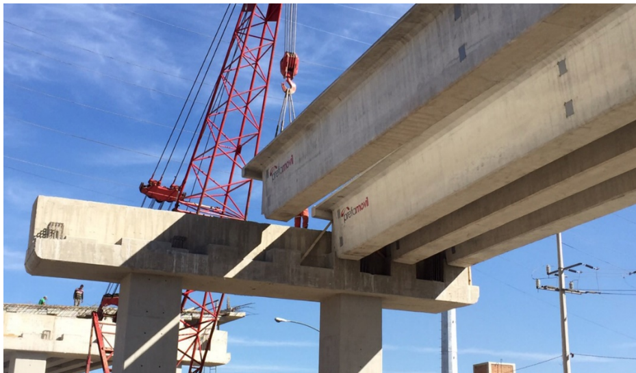
Figura 3: Imagen representativa de vigas prefabricadas de concreto.
