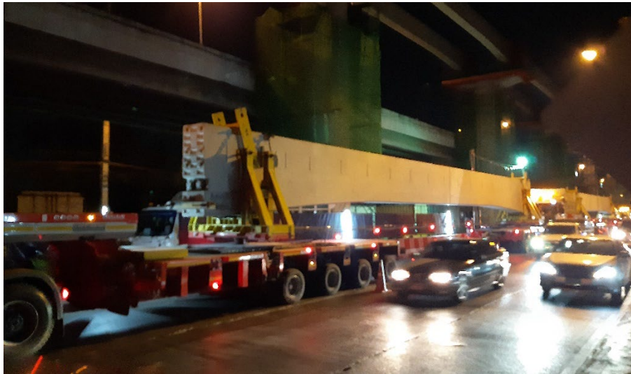
Figura 58 Transporte de viga prefabricada de concreto para monorriel
