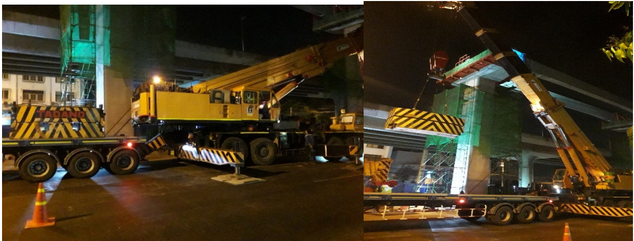
Figura 59 Grúas para izado de viga.
