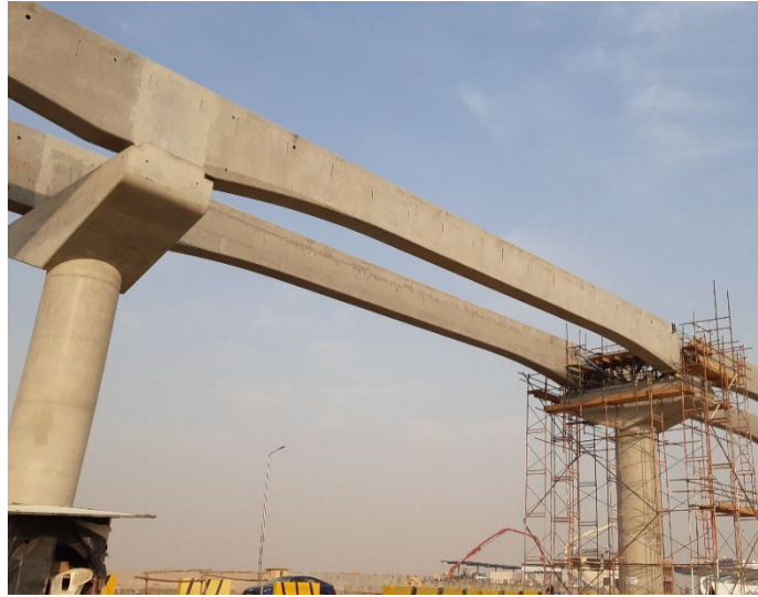
Figura 63 Tramo con junta intermedia colada en sitio.
