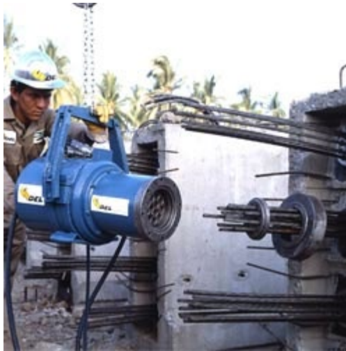
Figura 33 Imagen representativa de gato hidráulico multitorón tipo E.
