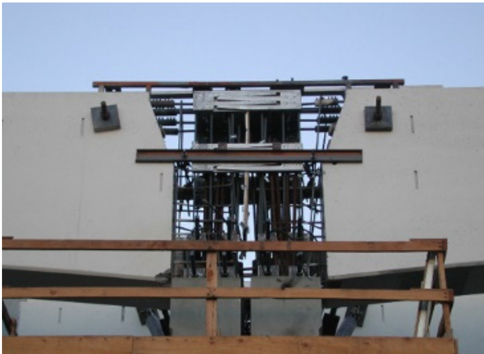
Figura 64 Colocación de junta expansiva en juntas externas previo al colado.
