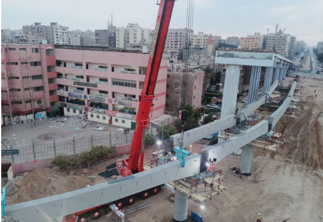
Figura 18 Izaje de vigas prefabricadas de concreto para el metro de Monterrey.
