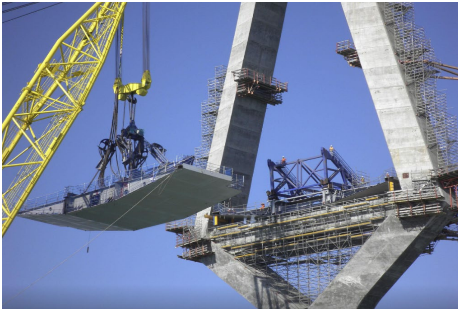
Figura 54 Izaje de dovelas prefabricadas con grúa.
