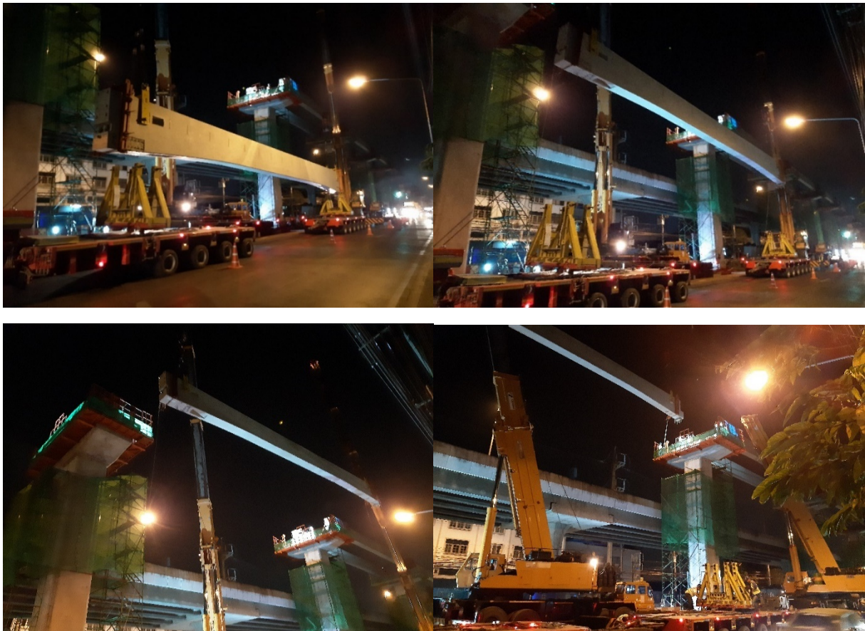
Figura 61 Secuencia de izado de viga para monorriel
