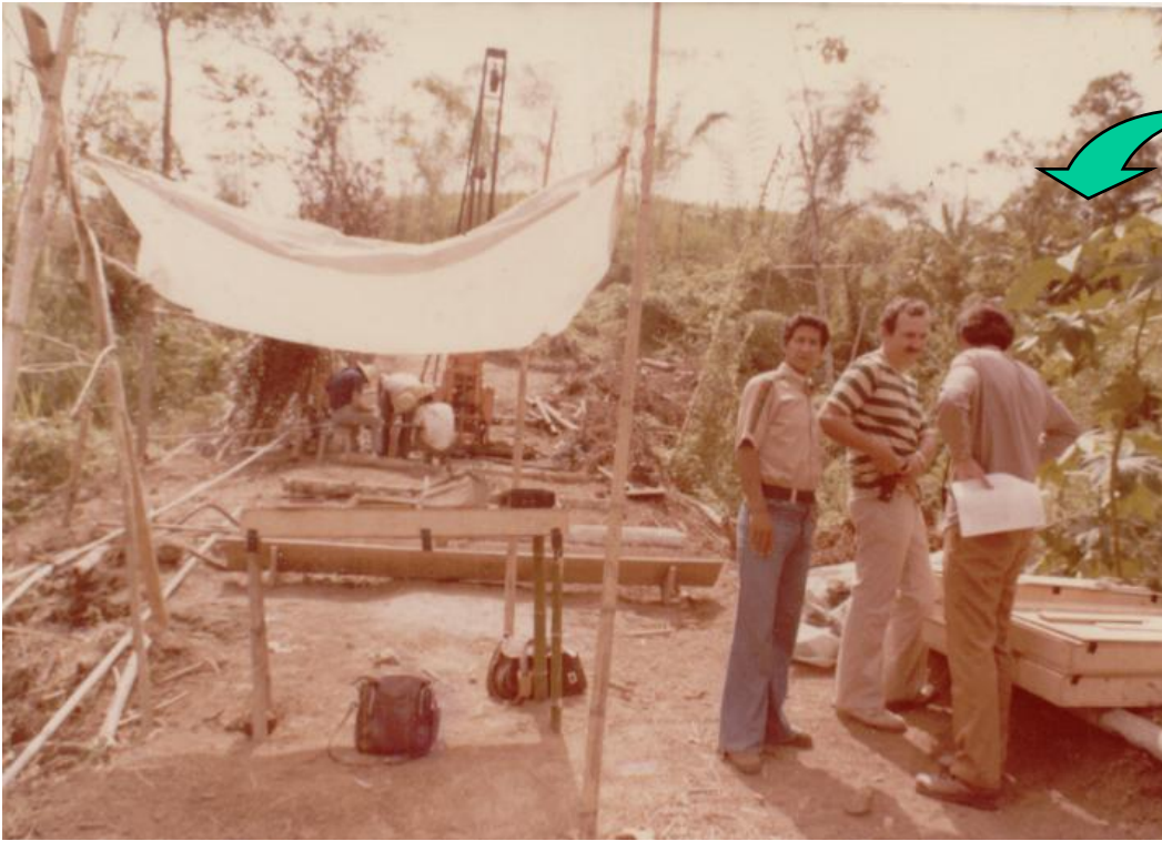
Perforación de sondeos mecánicos
