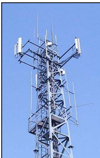
**FIGURA No 2.4: Ejemplo de una estación base**
