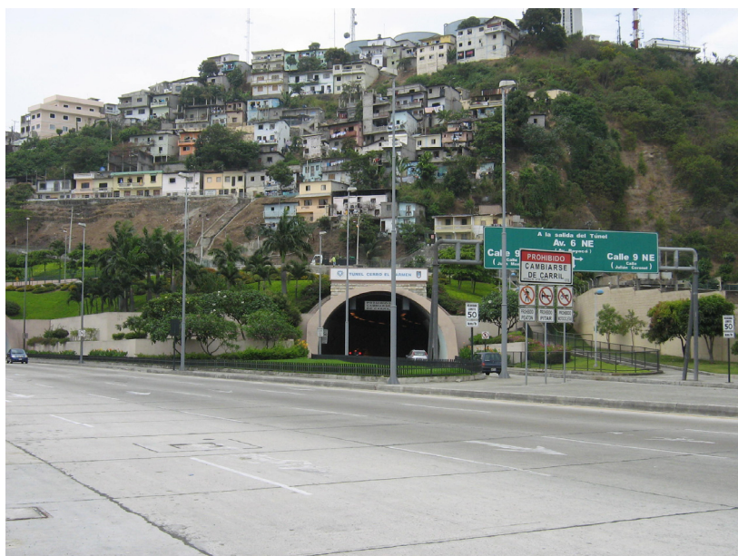
Figura 3.1 Ingreso al túnel del cerro El Carmen
