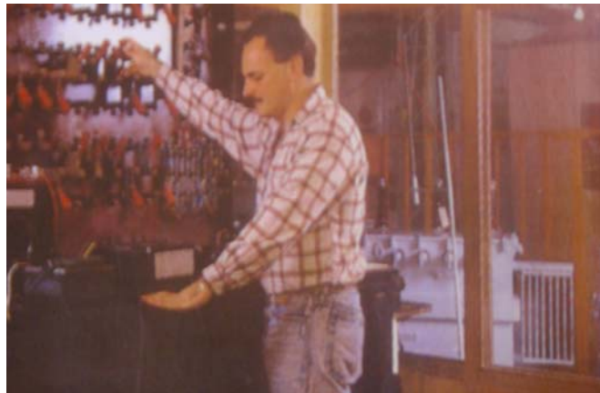
FIGURA 3.2 BANCO DE PRUEBAS DE LOS TRANSFORMADORES
