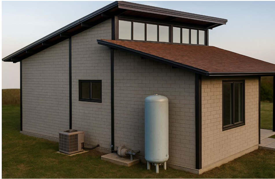
Figura 3.12 Implementación del sistema de aprovechamiento de agua lluvia compuesta con un tanque de almacenamiento y bomba presurizadora
