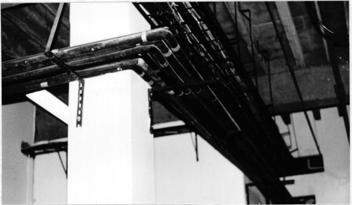
ANCLAJES PARA TUBERIA - AEREOS
