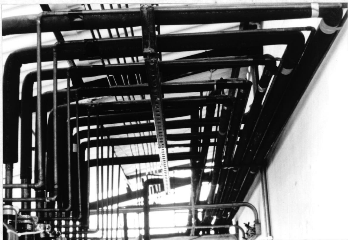
ANCLAJES DE TUBERIA - ACOMETIDA
