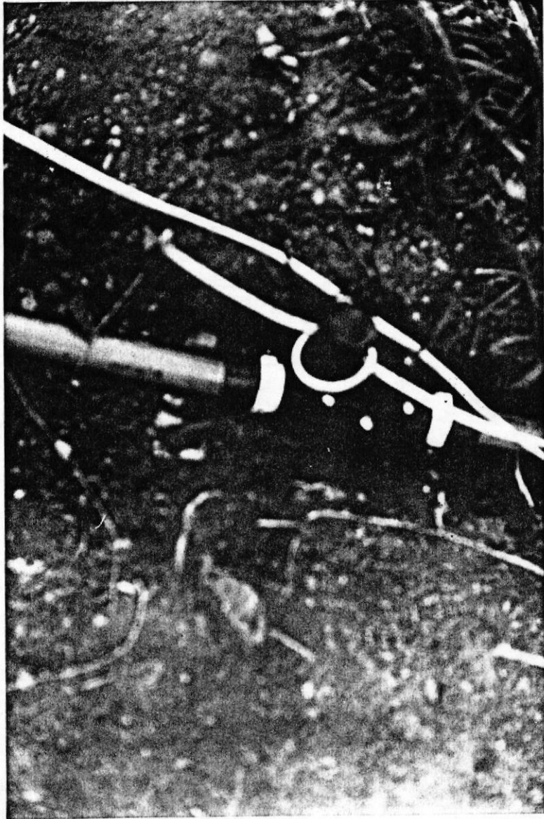
fig. 16 Instalación de tubería primaria y válvula solenoide
