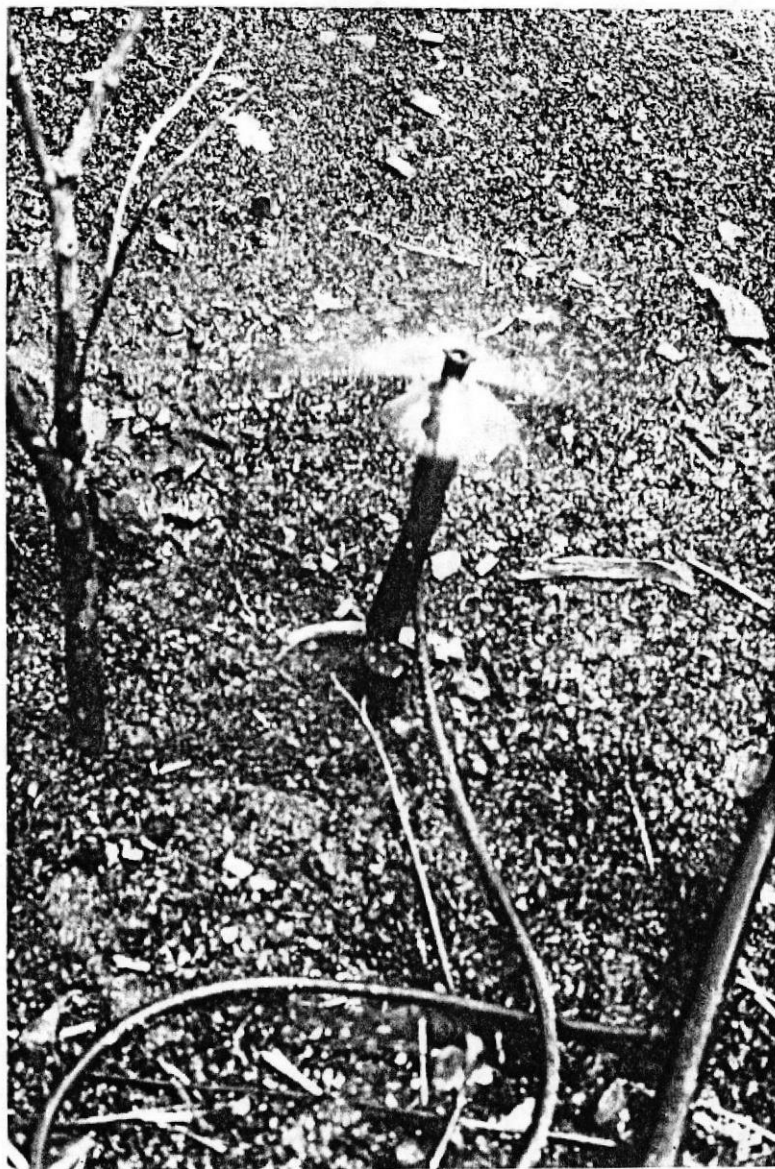
fig. 15 Instalación de estaca porta microaspersor y microaspersor.
