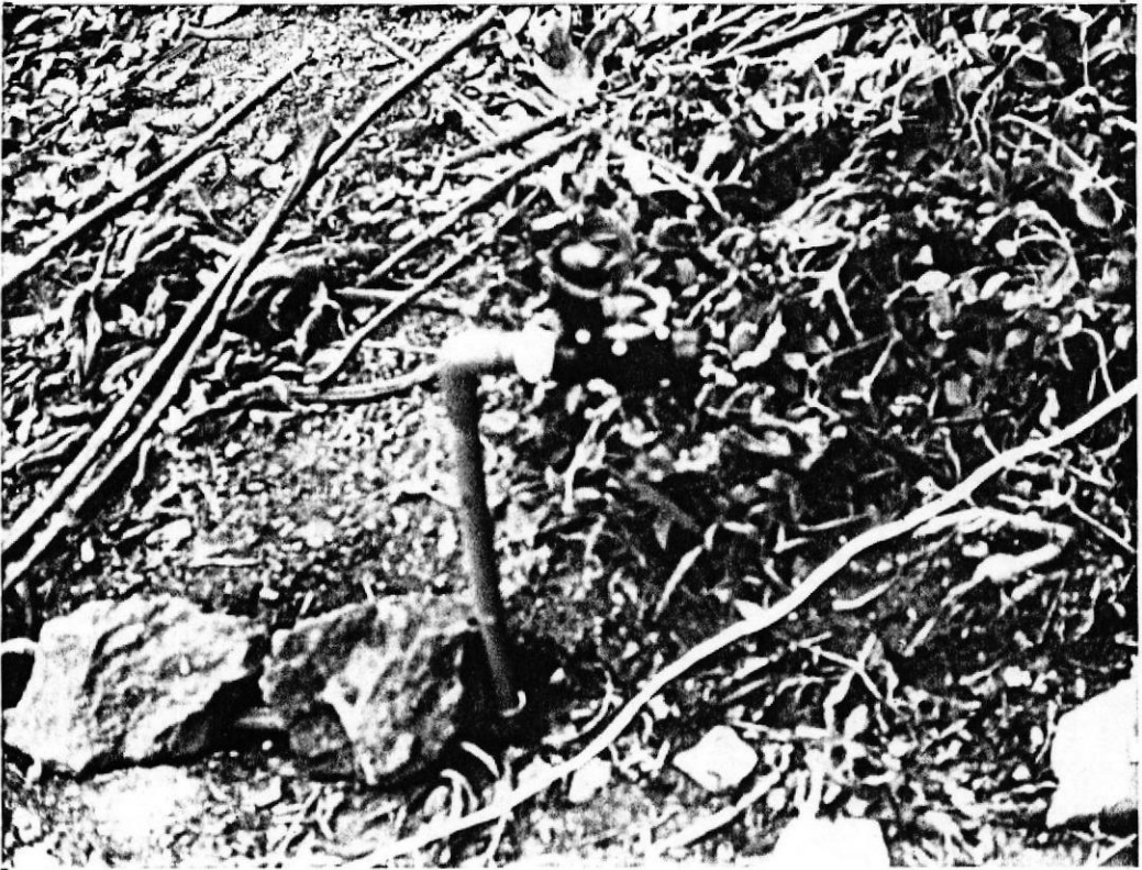
fig. 14 Instalación de Válvula solenoide.
