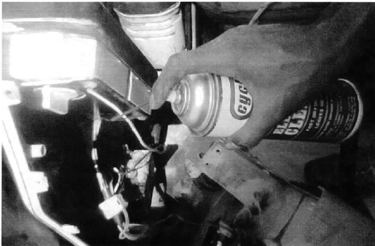
LIMPIEZA DE LOS CONTACTOS DEL TABLERO DE INSTRUMENTOS
