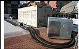
La maquina enfriadora junto al buffertank y conectada a la pista de hielo
