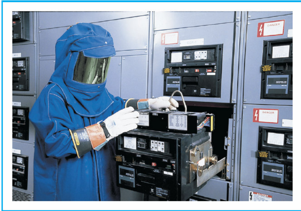
Figura 7.1. Trabajador eléctrico utilizando el equipo de protección personal.
