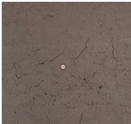
FIGURA 3.2 FISURA SUPERFICIAL
