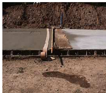
FIGURA 3.5 CURADO CON MEMBRANA
