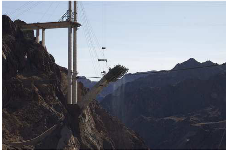
FIGURA 2.12 CONSTRUCCIÓN DE UN PUENTE DE HORMIGÓN
