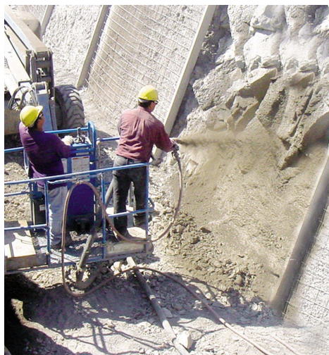
FIGURA 2.14 HORMIGÓN LANZADO (SHOTCRETE)
