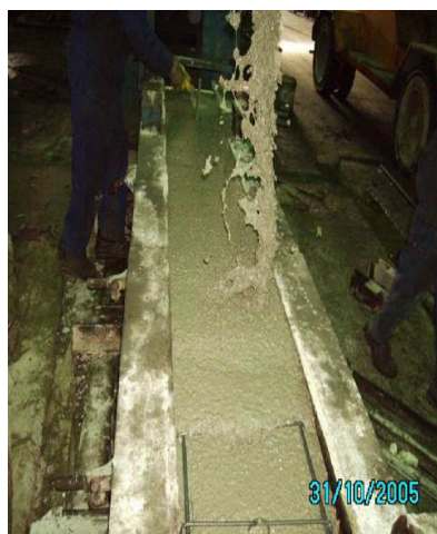
FIGURA 2.11 VERTIDO DE UNA VIGA CON HAC
