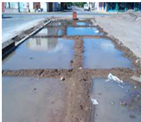
FIGURA 3.4 LOSA INUNDADA PARA MEMBRANA
