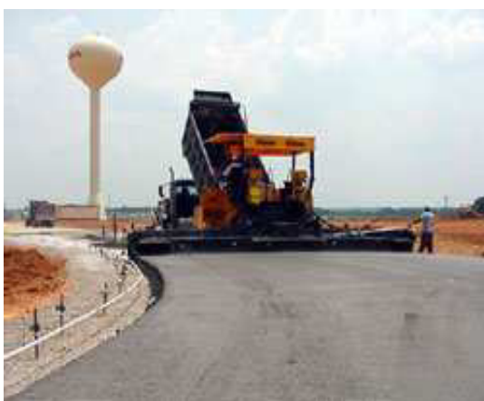
FIGURA 2.1 USO DE PAVIMENTADORA PARA COMPACTACIÓN DEL HCP Y RODILLOS VIBRATORIOS PARA SEGUNDA ETAPA.
