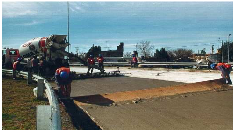
FIGURA 2.3. COMPACTACIÓN CON REGLA Y EL TEXTURADO CON ARPILLERA HÚMEDA
