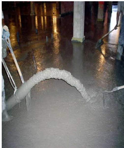
FIGURA 2.5 VERTIDO DE UN HORMIGÓN AUTOCOMPACTANTE.
