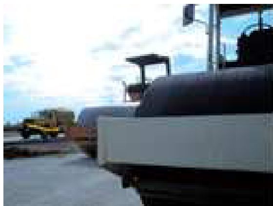
FIGURA 2.1 USO DE PAVIMENTADORA PARA COMPACTACIÓN DEL HCP Y RODILLOS VIBRATORIOS PARA SEGUNDA ETAPA.
