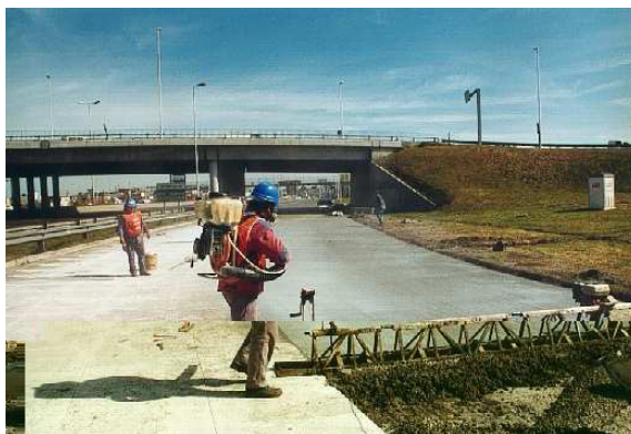
FIGURA 2.4. APLICACIÓN DE MEMBRANA QUÍMICA DE CURADO MEDIANTE EQUIPOS PORTÁTILES (MOCHILA)
