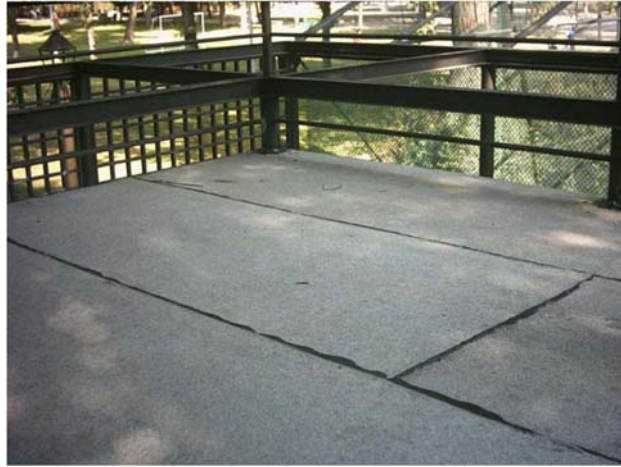
Fotografía 14. Membrana de Impermeabilización.
