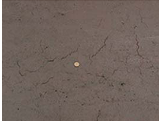
Fotografía 4. Fisuración superficial
