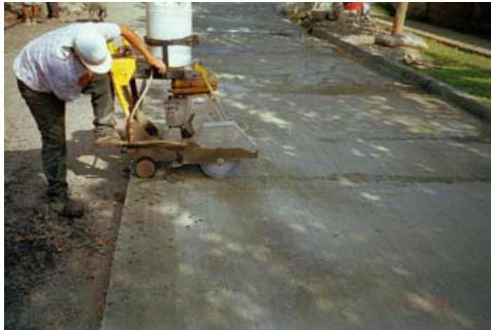
Fotografía 9. Aserramiento mecánico de una junta de contracción.
