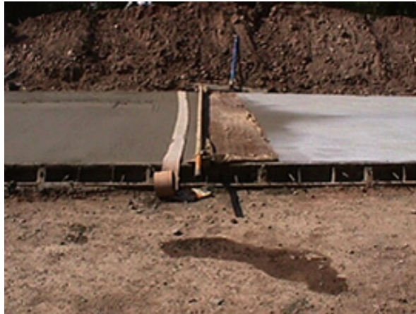
Fotografía 11. Curado con membrana.
