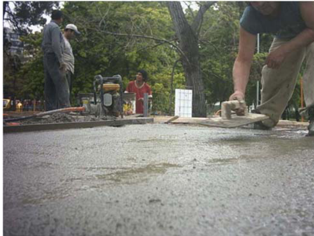
Fotografía 12. Fratasado de losa de hormigón.
