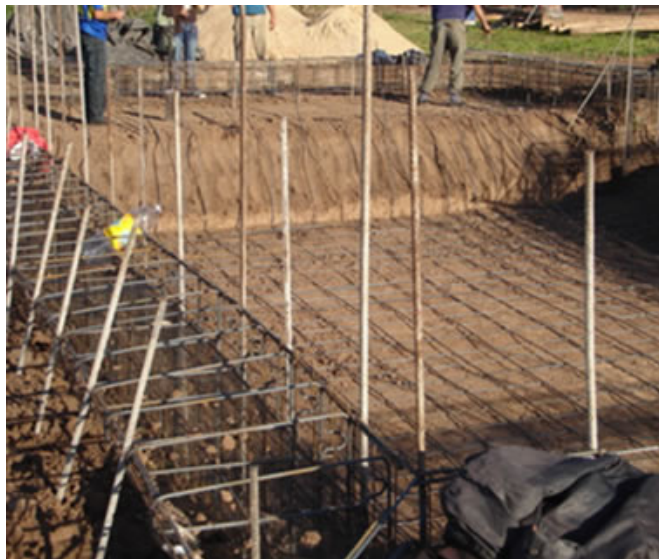
Fotografía 7. Colocado de armadura de hierro en una piscina.
