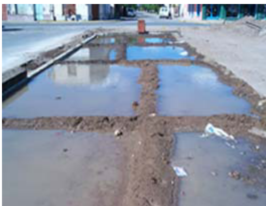
Fotografía 10. Losa inundada para curado
