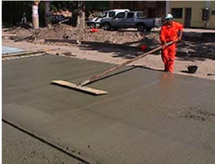
Fotografía 13. Acabado superficial de un pavimento de hormigón.
