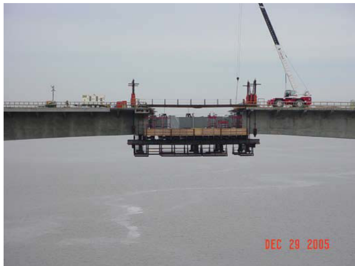
Fig 13. Proceso de construcción de dovelas
