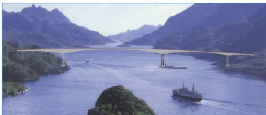
Fig 04. Vista panorámica de puente Raftsundet.
