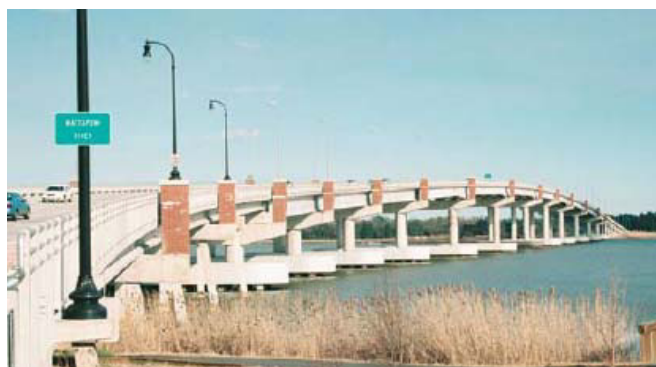
Fig 07. Ruta 33, puente sobre el río Mattaponi
