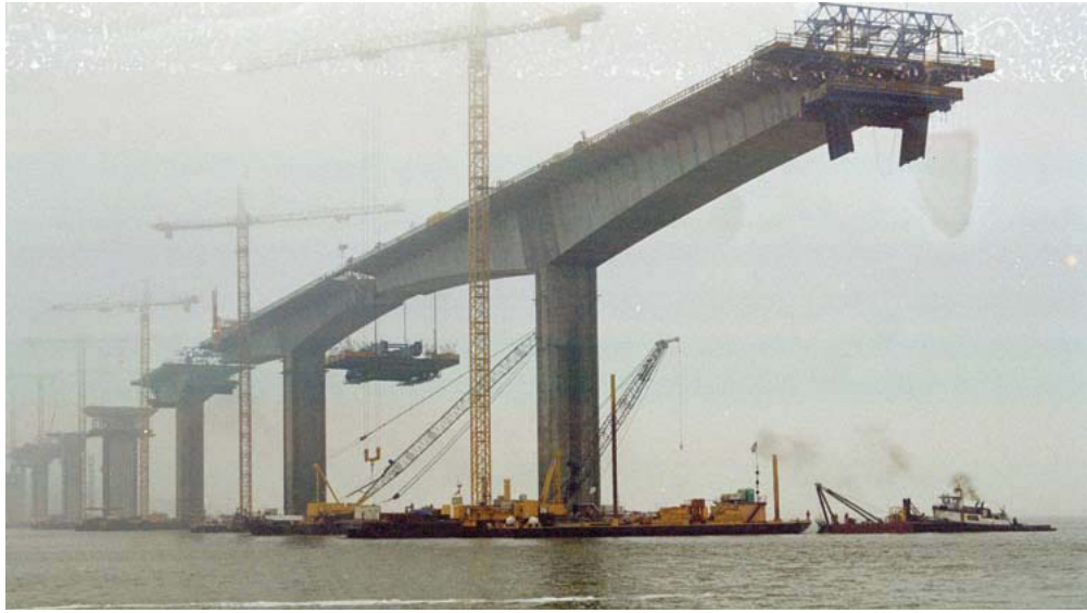
Fig 12. Proceso de construcción de dovelas
