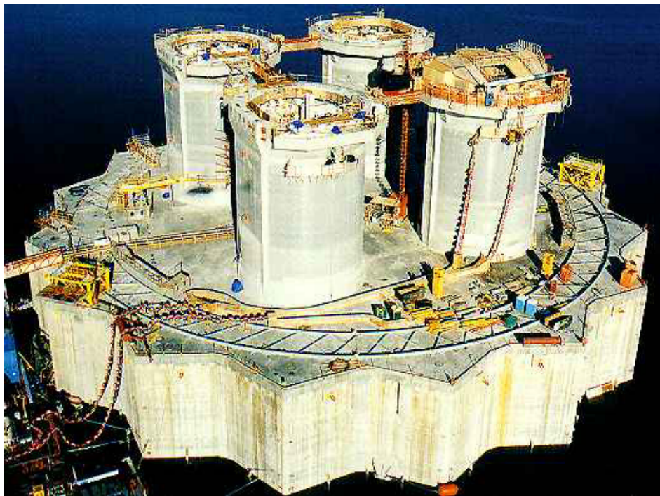
Fig 09. Base estructural de la plataforma Hibernia parcialmente sumergida
