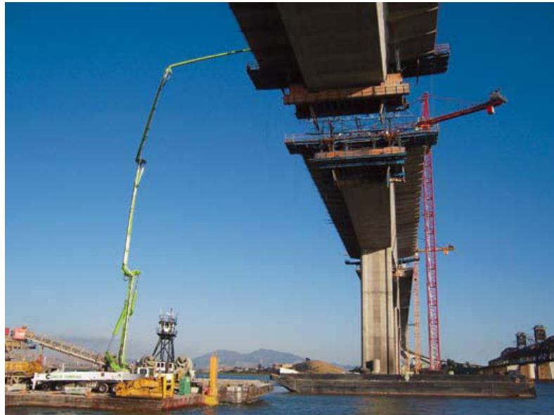
Fig 14. Bombeado de hormigón para fundición de dovelas
